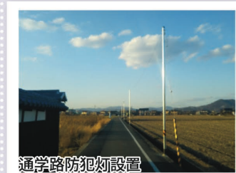
通学路防犯灯設置
