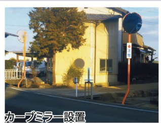
カーブミラー設置
