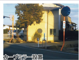
カーブミラー設置
