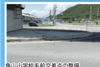
角山小学校手前交差点の整備
